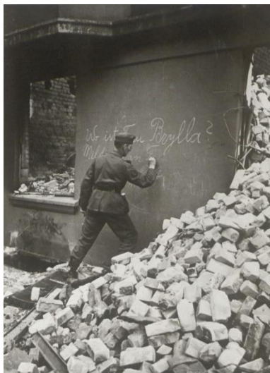
Suche nach Vermissten in den Trümmern
